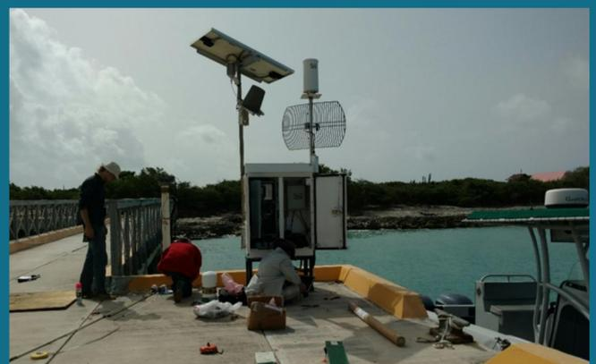
Figura 21: Personal de RSPR realizando trabajos de mantenimiento en el mareógrafo.
